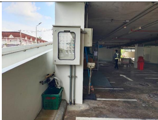
รูปที่ 2-10 การติดตั้งระบบควบคุม และมิเตอร์ไฟฟ้าสำหรับระบบบำบัดน้ำเสีย
